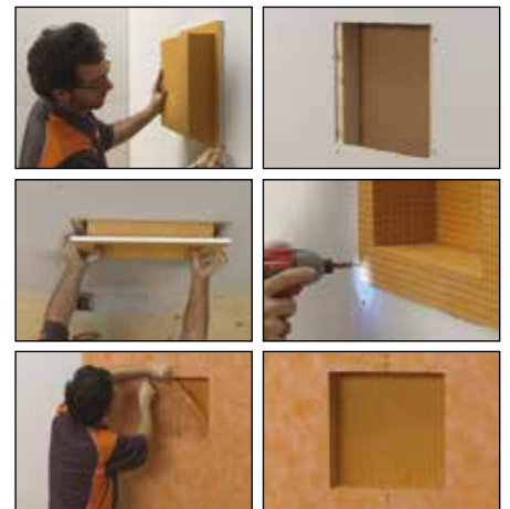
Mise en œuvre sur plaques de plâtre
