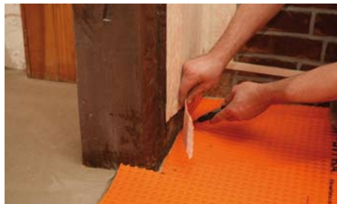
Lorsque le ragréage est sec, la natte de désolidarisation peut être posée sur le support préparé. Préalablement découpée aux dimensions souhaitées à l'aide d'un cutter, elle est collée sur le sol ragréé.
