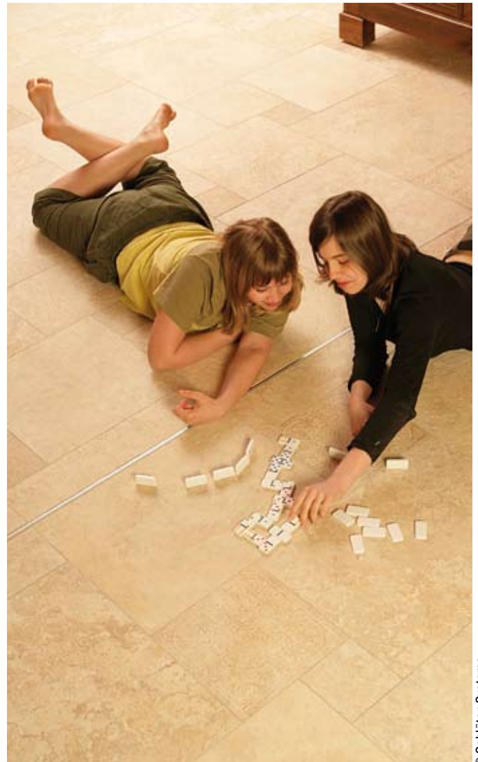
Le revêtement de sol terminé transforme totalement l'esthétique de la pièce et le calepinage des quatre formats permet d'éviter l'effet quadrillage généré par les joints.
