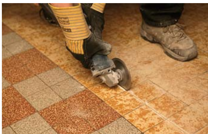
Le revêtement est scié à l'emplacement du futur joint de fractionnement.
