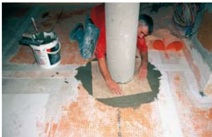
Le soin apporté aux points singuliers est primordial pour la pérennité du site : les piliers sont habillés pour éviter les infiltrations.
