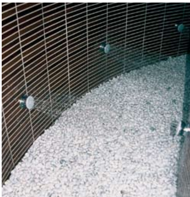
Les projections d'eau, une des difficultés techniques de ce chantier.
