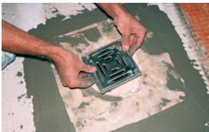
Le choix et la mise en œuvre des siphons respectent l'Avis Technique obtenu par Schlüter-Systems.
