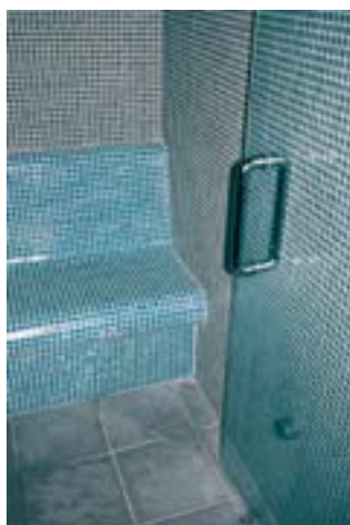
La structure de la banquette du hammam a été montée dans l'usine Lux Elements.
