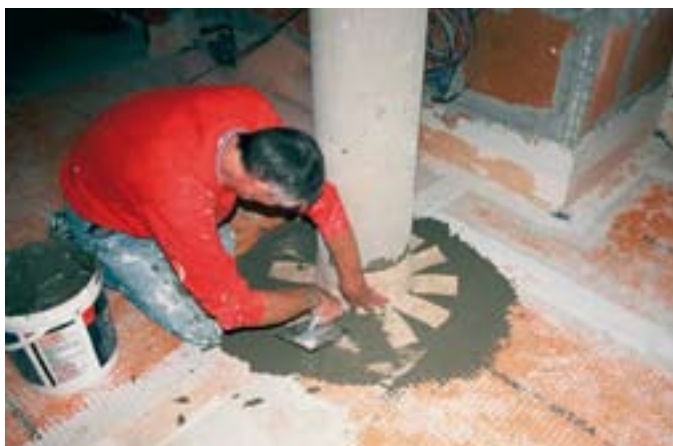
Le soin apporté aux points singuliers est primordial pour la pérennité du site : les piliers sont habillés pour éviter les infiltrations.
