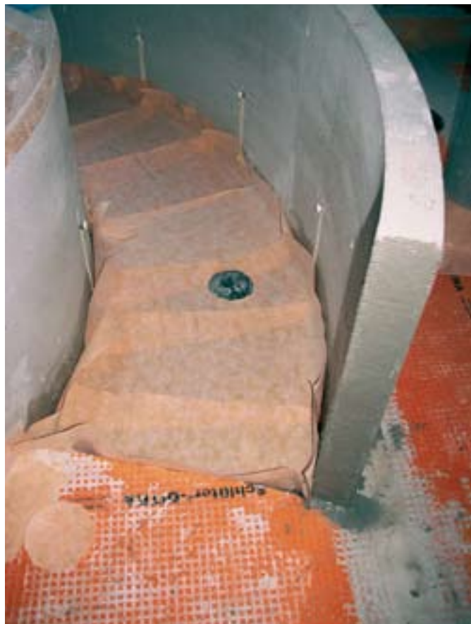
La forme du parcours de galets est réalisée à l'aide des produits Lux Elements et l'étanchéité au sol est assurée par la bande Schlüter®-Kerdi, qui remonte sur les parois.
