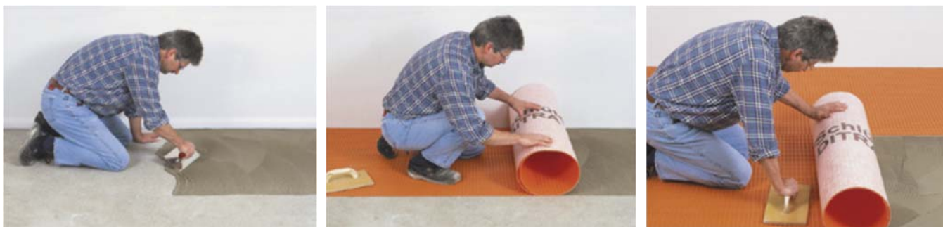
Figure 5 – Mise en œuvre de la natte
