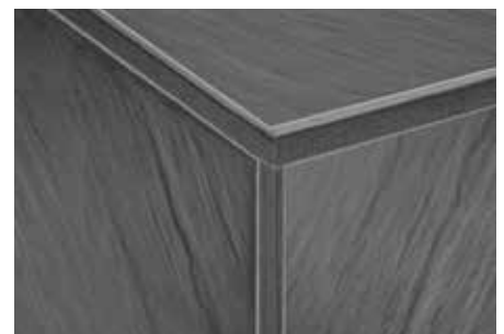
Réalisation d'angles avec coupe en onglet
