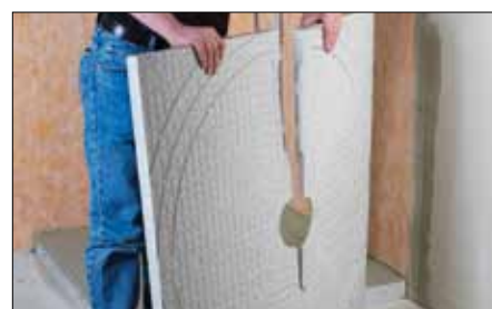
12a Assembler le receveur avec pente ...
