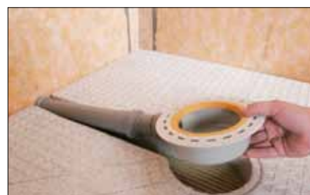
9 ... raccorder l'ensemble à la conduite d'évacuation du bâtiment.
