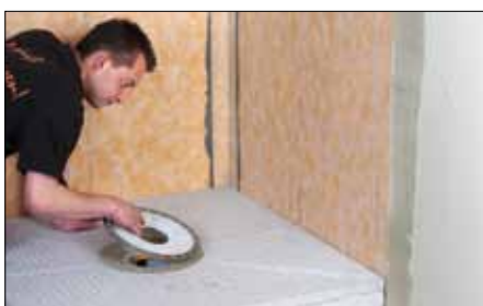
15 Insérer l'avaloir rapporté dans le corps du siphon et l'enfoncer dans le mortier-colle.
