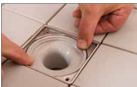
23 Avant la mise en service, dévisser la grille en inox et contrôler la bonne fixation du siphon en appuyant dessus (le cas échéant, graisser le joint torique).
