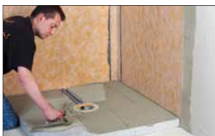
11 Déposer du mortier-colle sur le panneau de mise à niveau.
