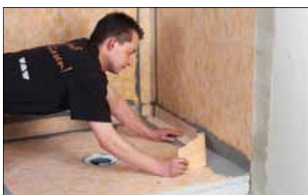
20 b Réaliser également l'étanchéité des liaisons sol/mur avec la bande Schlüter®-KERDI-KEBA collée avec la colle Schlüter®-KERDI-COLL.
