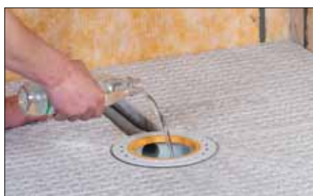
10 Procéder à un contrôle d'étanchéité.
