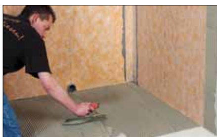
5 Déposer du mortier-colle sur le support plan.
