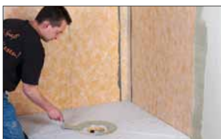
13 Appliquer du mortier-colle dans l'espace destiné à recevoir la platine de l'avaloir.
