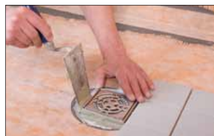
22 Caler la grille en inox avec du mortier-colle et l'ajuster à la hauteur des carreaux.
