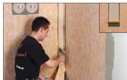
3 Ponter les lés avec la bande Schlüter®-KERDI-KEBA collée avec la colle Schlüter®-KERDI-COLL.
