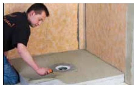
17 Déposer du mortier-colle sur le reste de la surface (spatule crantée de 3 x 3 mm ou de 4 x 4 mm).
