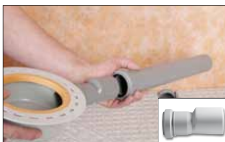
8 Ajuster le tuyau d'évacuation sur le corps du siphon Schlüter®-KERDI-DRAIN. Si nécessaire, utiliser la pièce de réduction fournie et ...
