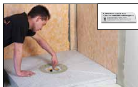
14 Appliquer du lubrifiant sur la lèvres d'étanchéité du corps du siphon.
