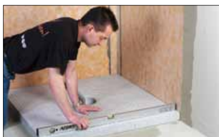
7 Lors de la pose avec des plots de mortier, ajuster le panneau de mise à niveau à l'aide d'un niveau.
