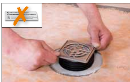
21 Insérer la grille en inox avec son support dans l'avaloir rapporté.
