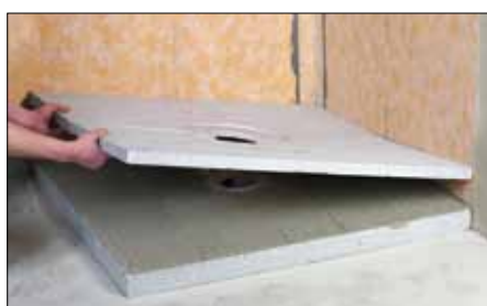
12b ... et le poser. (Attention : la jonction du panneau ne doit pas se superposer à la conduite d'évacuation).
