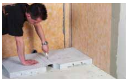
4 Découper le passage de la canalisation à l'aide d'un cutter.
